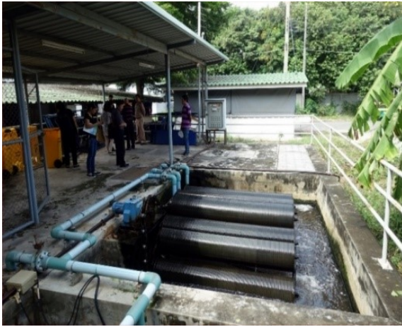
Hình 34. Sơ đồ thiết bị đĩa quay sinh học
